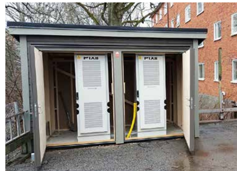
Batteri för solcellsel, Farsta.
