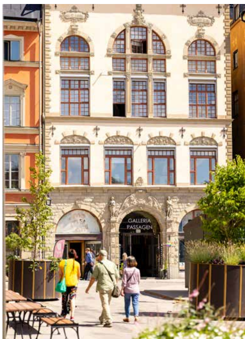
Kornhamnstorg 49, Gamla stan.
