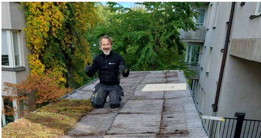
Andreas Antonsson monterar återbrukat tak med sedum på Ruddammsvägen/Brunbärsvägen, Östermalm.
