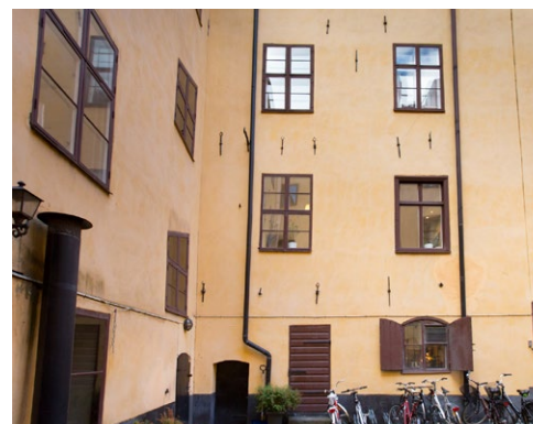
Stora Nygatan 21, Gamla stan.
