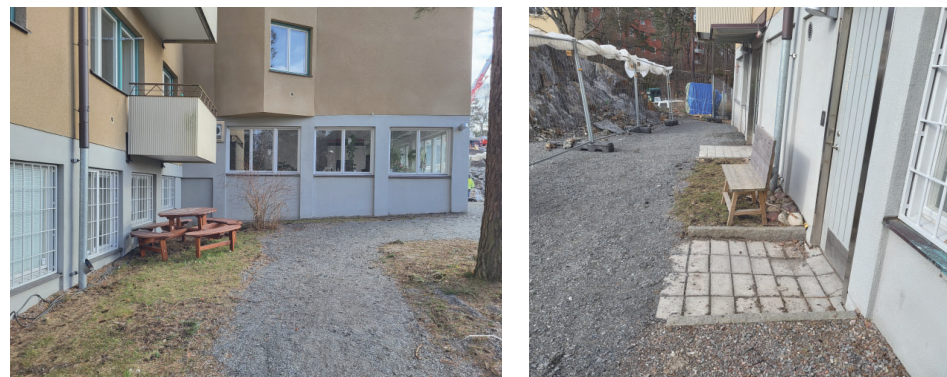
Befintlig yta som görs om till uteplats och befintliga ingångar som fräschas upp.
